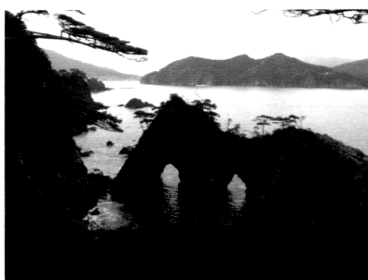
図2 | 三陸復興国立公園碓石海岸より大船渡湾を望む。大津波で破壊した湾口防波堤は再構築中(2013年8月21日撮影)[すべて筆者撮影]
