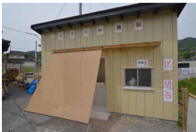
（写真 6-35） 完成したキッチンスペース
