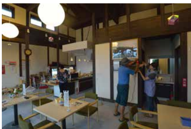
(写真 7-1) 掲示ラックの設置
