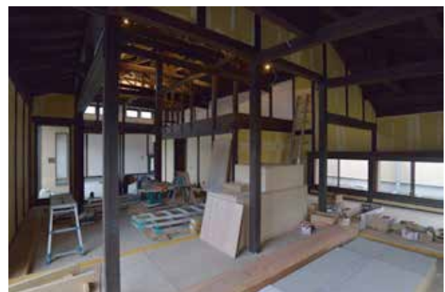
(写真 2-6) 竣工間近の居場所ハウス
