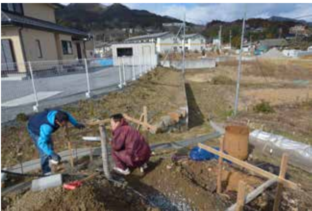
(写真 7-13) キッチンスペースの建設工事
