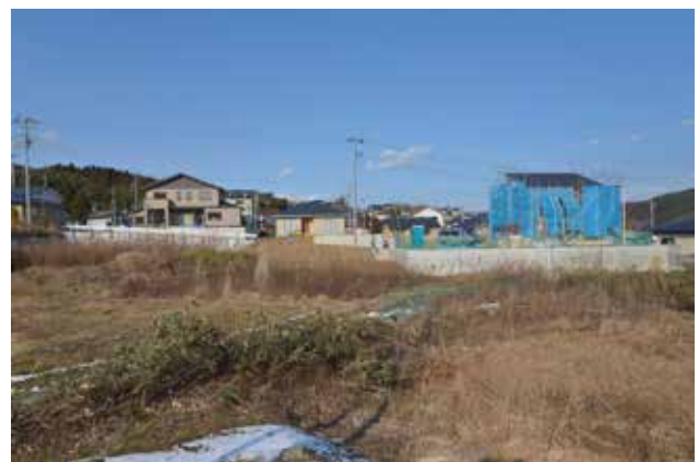
(写真 8-10) 防災集団移転地では住宅建設が進む
