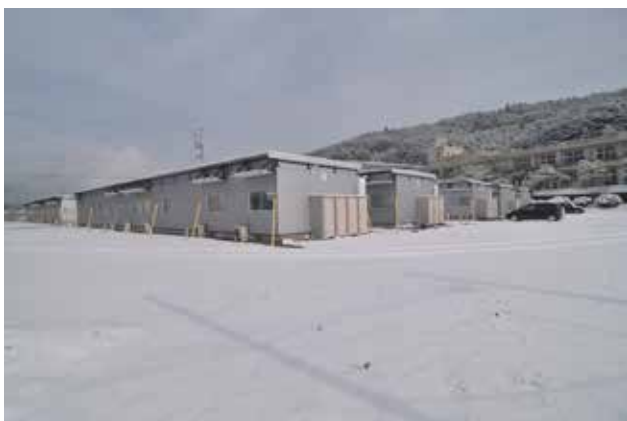
（写真 2-9） 山岸仮設団地
