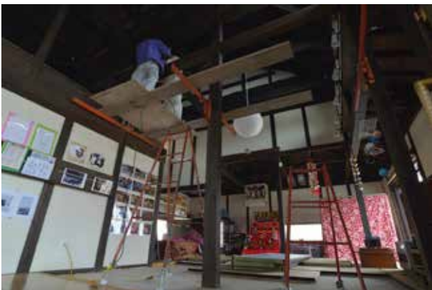
(写真 7-3) 土間と和室の間の柱の撤去
