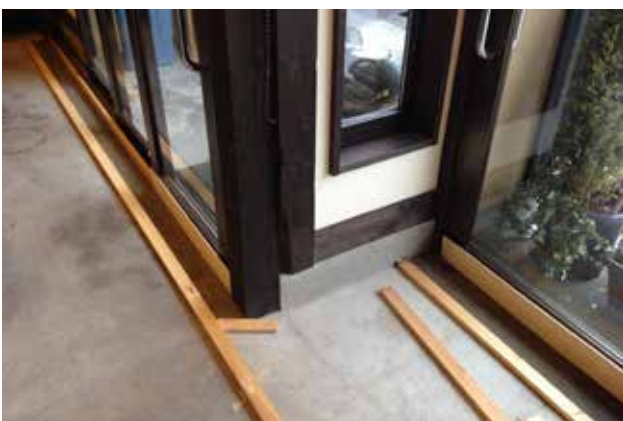
(写真 7-5) 土間部分の浸水防止工事
