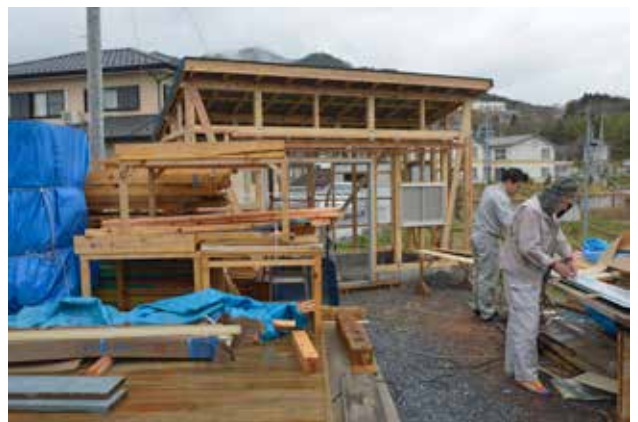
(写真 7-14) キッチンスペースの建設工事
