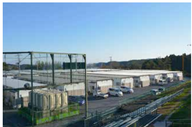
（写真 2-10） 大田仮設団地
