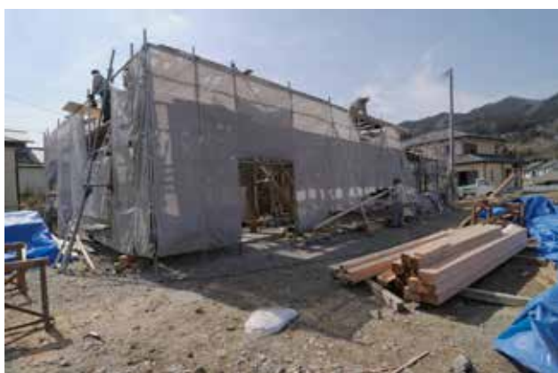
(写真 2-5) 建物の施工
