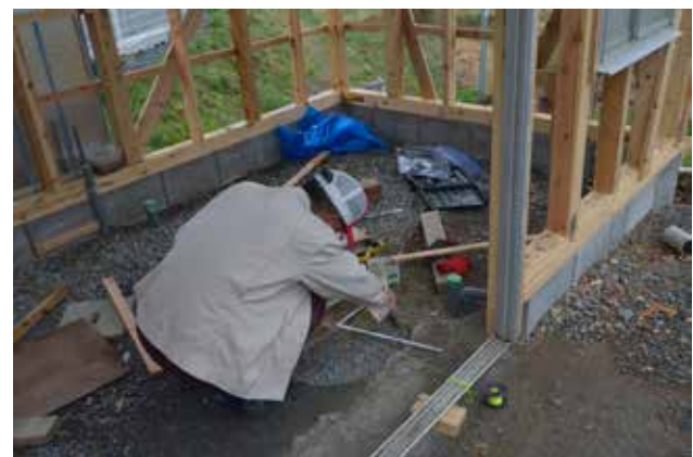
（写真 6-32）キッチンスペースの建設工事
