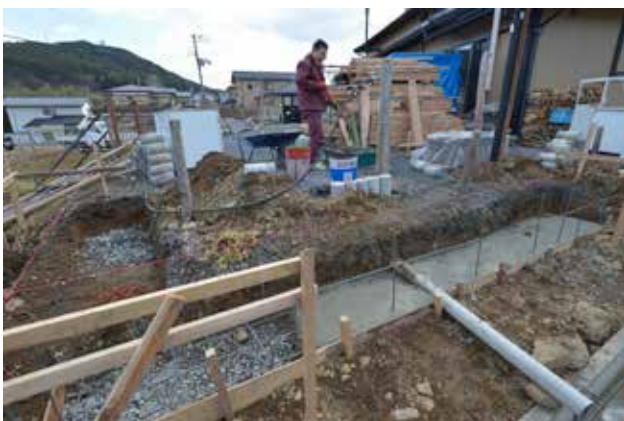
（写真 6-31）キッチンスペースの建設工事
